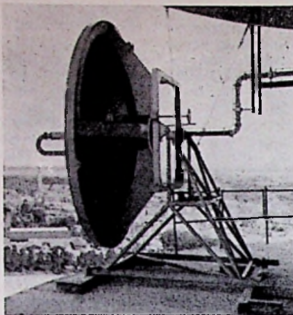
Siemens parabool-antenne voor straalverbindingen o.a. voor overdracht van het N.T.S.- en Eurovisie-programma. TV-toren te Roermond.
